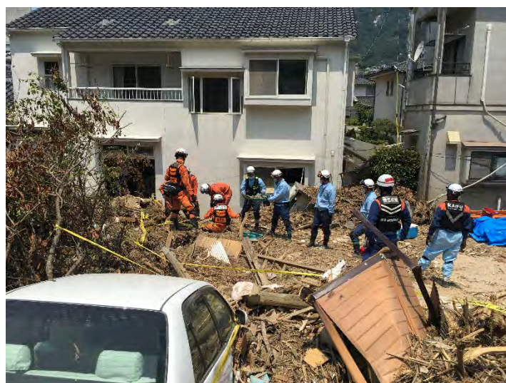
捜索活動の様子 【安芸郡坂町小屋裏】 (撮影 徳島市消防局)
